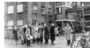
Postende stakers bij toegangspoort aan de Friesestraatweg
